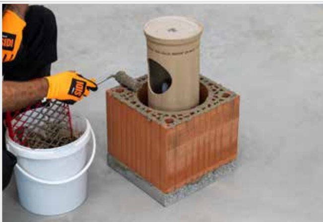
NANIESIENIE ZAPRAWY MURARSKIEJ NA SPOINĘ
