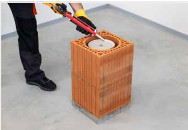
NANIESIENIE MASY USZCZELNIAJĄCEJ NA ZBIORNIK
