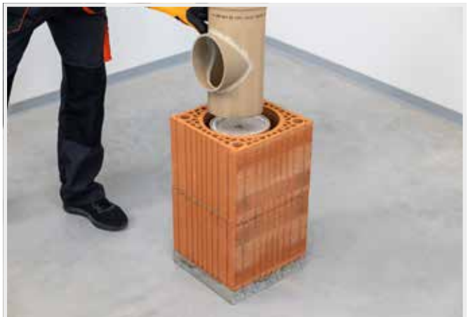
OSADZENIE WYCZYSTKI (BŁOCZEK BEZ IZOLACJI)
