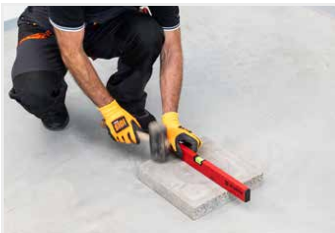
WYRÓWNANIE STOPY FUNDAMENTOWEJ.
