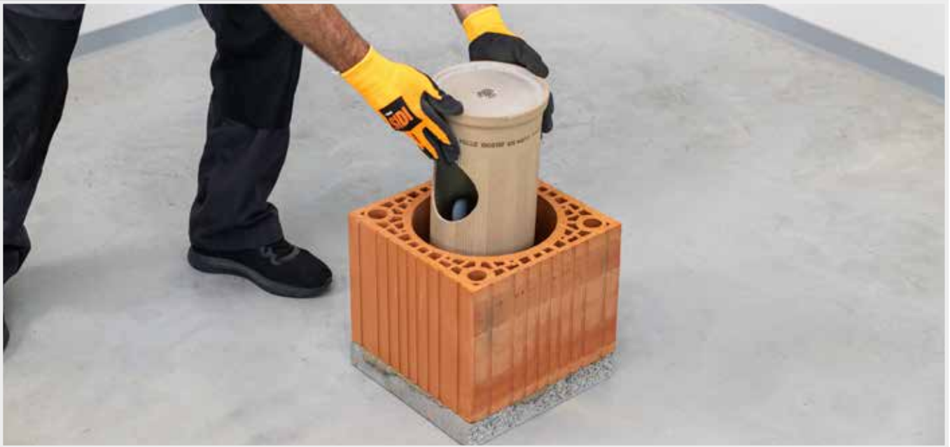
OSADZENIE ZBIORNIKA KONDENSATU
