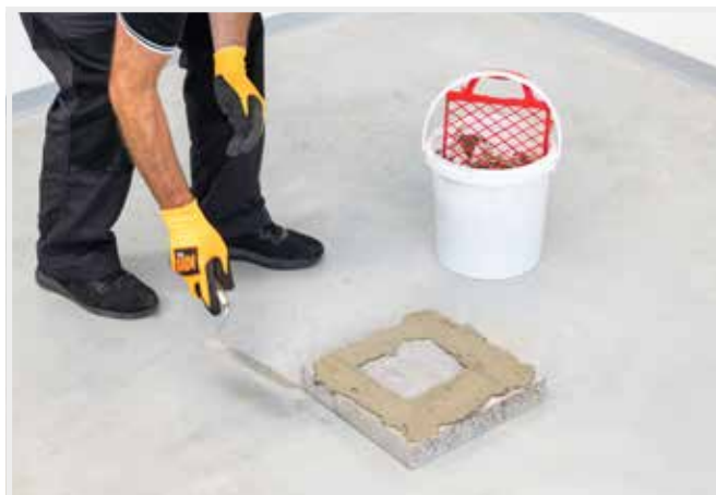
NANIESIENIE ZAPRAWY MURARSKIEJ
